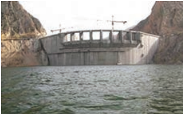
شکل ۸- سد لار در تهران، در مکان مناسبی احداث نشده است.
