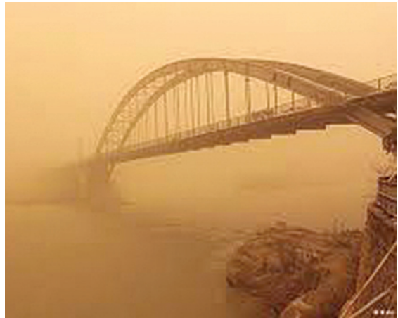
شکل ۳- الف) آلودگی ناشی از ریزگردها- اهواز
